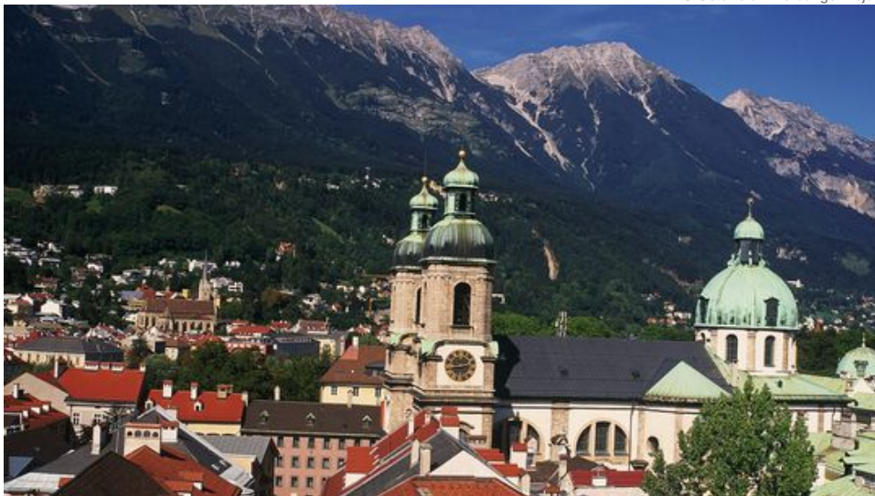
Blick über die Stadt Richtung Norden
